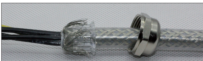
5. Trekk plastikk foringen tilbake til der hvor ytterkappen er kappet og trekk skjermen tilbake over den. over kabelen og fjern innerskjermen fra lederne.
